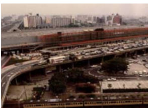
新大阪駅 新幹線0番ホーム増設工事
